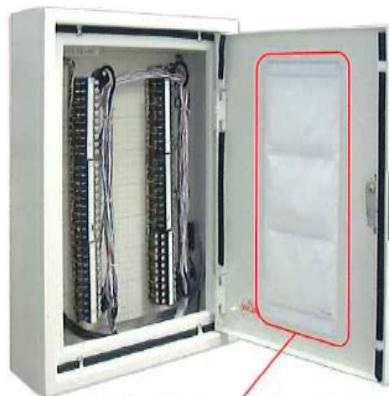
通信専用端子盤へのG-Press施工例
